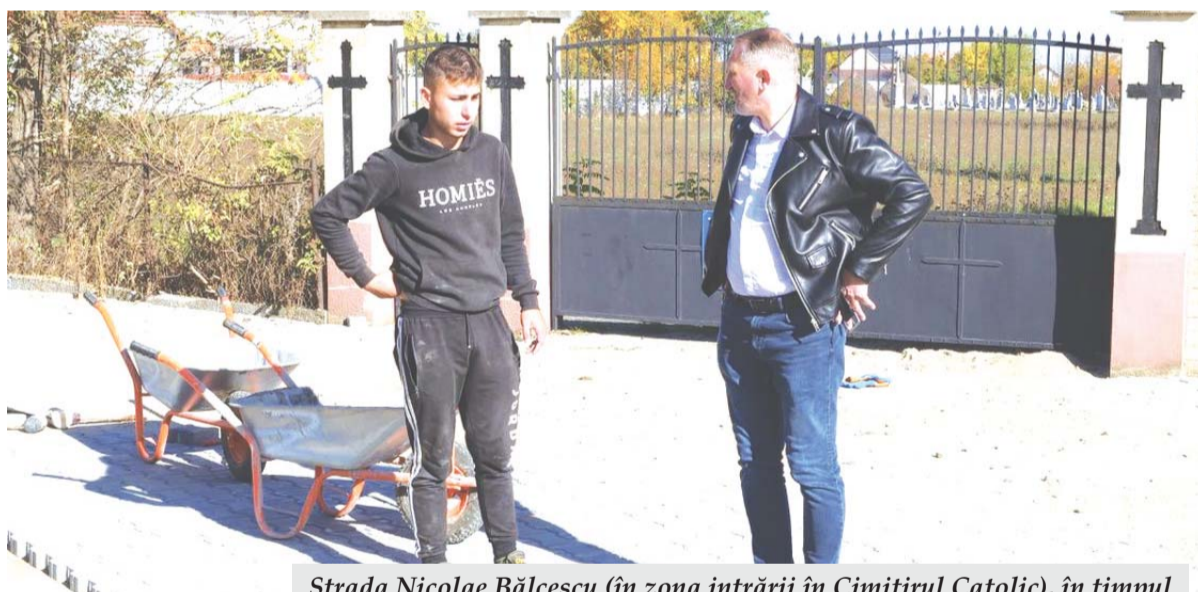
Strada Nicolae Bălcescu (în zona intrării în Cimitirul Catolic), în timpul lucrărilor (fotografia de sus) și la finalizarea acesteia (fotografia de jos). Primarul Mihai Mag, prezent pe șantierul investiției, se declară mulțumit de calitatea lucrării și de aspectul modern al zonei
