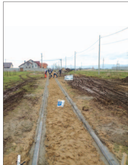
La Horia, la ieșirea din localitate spre Șiria, în Cartierul nou, se amenajează un trotuar
