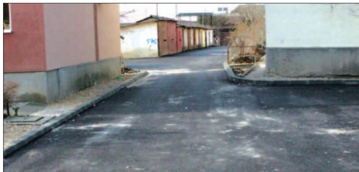
Intrarea dinspre str. Libertății; se poate observa că s-au montat borduri pentru a se evita ca, pe viitor, apa să se scurgă spre fundația blocurilor
