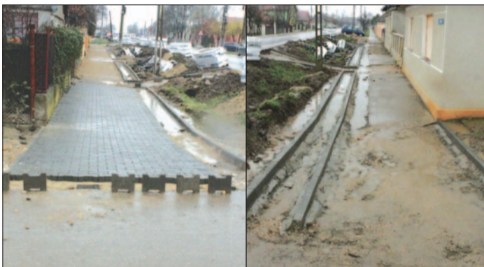
Lucrările la trotuarul de pe str. Gării sunt în toi
